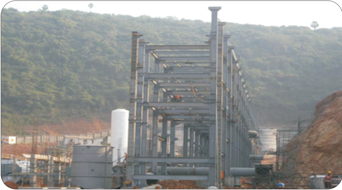
विशाखापटनम् साईट पर पाइप रैक निर्माणाधीन
